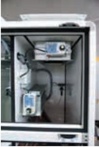
Verifique los amortiguadores para facilitar movimiento. Nunca engrase los amortiguadores. Esto podría destruir el plástico usado y comprometer la función del amortiguador. Para limpiarlo, lávelo con solución jabonosa. En caso contrario no necesita mantenimiento. Los motores no necesitan mantenimiento. En intervalos regulares verifique que la conexión entre el servomotor y el amortiguador esté bien situada.
