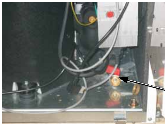
plnicí a vypouštěcí kohout okruhu solanky
